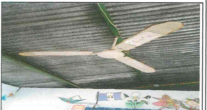
Foto 4: Sustitucion e intalacion electrica y ventilador de techo
