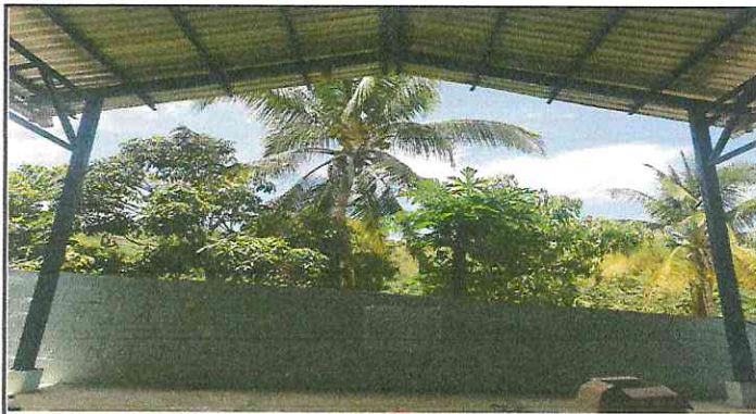
Foto 3: Ampliacion de altura de muro perimetral com marco de maya galvanizada
