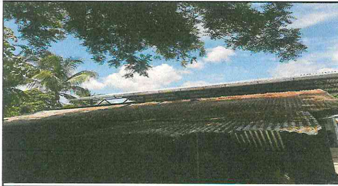
Foto1: sustitucion de lamina por lamina calibre 26
