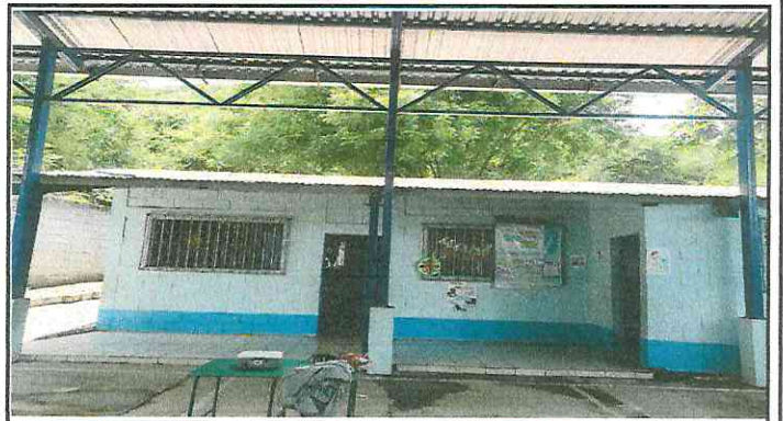
Foto 2: Instalacion de canal y bajada de saluzinc
