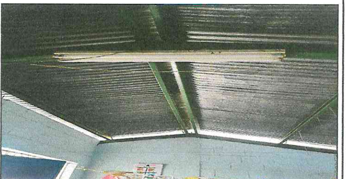
Foto 6: Mantenimiento a estructura (lijado, cambio de tubo , cepillado, sujeciones, aplicacion de pintura)
